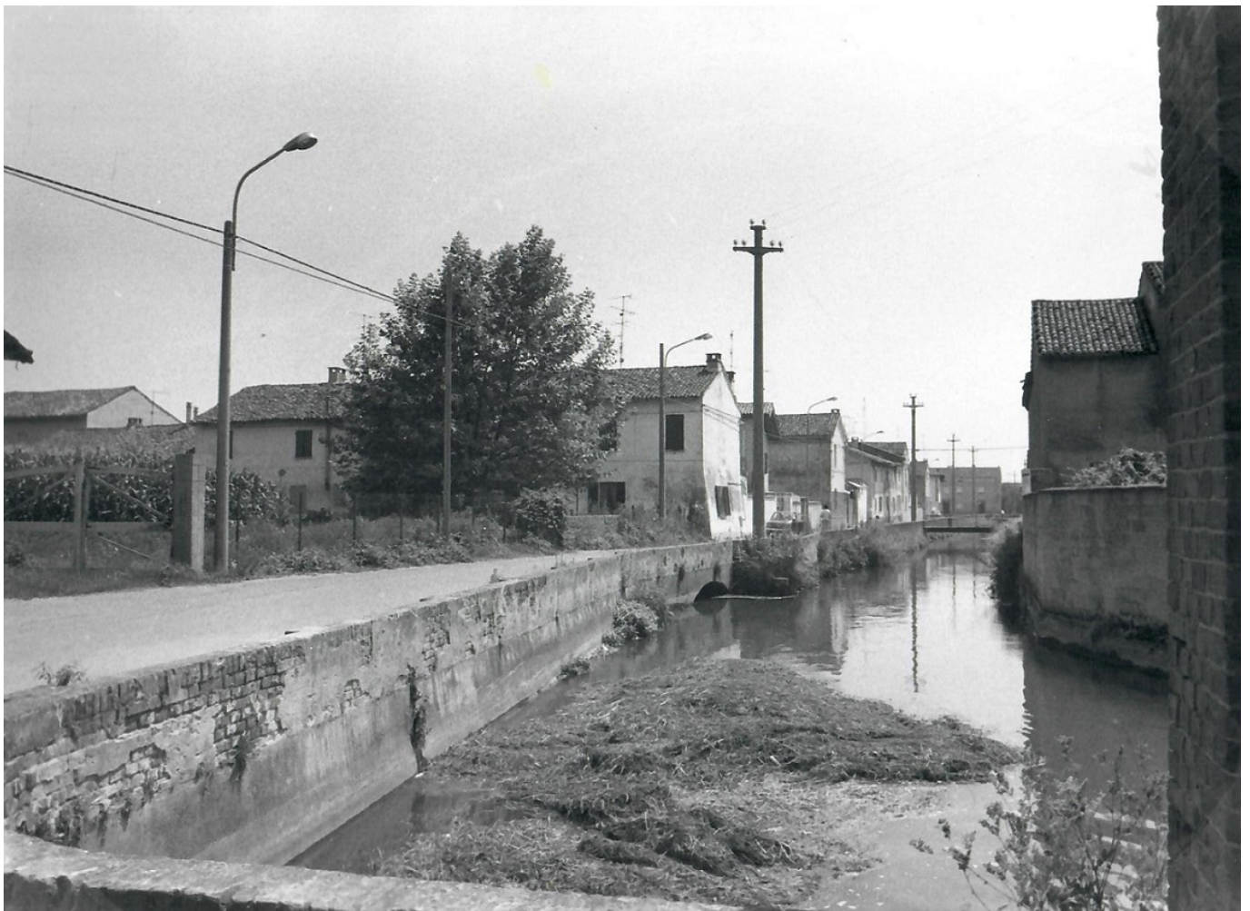
Figura 4, via molino costa vista dal mulino
