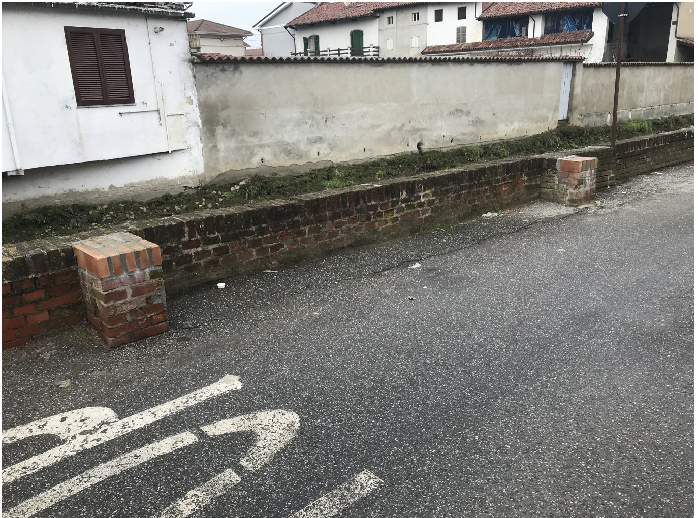
Figura 5, muretto che costeggia la roggia; ancora oggi si possono notare le originarie aperture.
